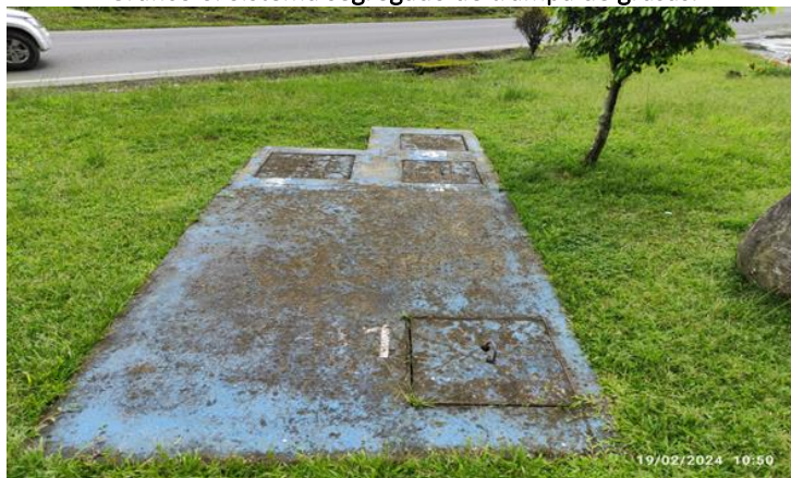
Gráfico 6. Sistema segregado de trampa de grasas.
