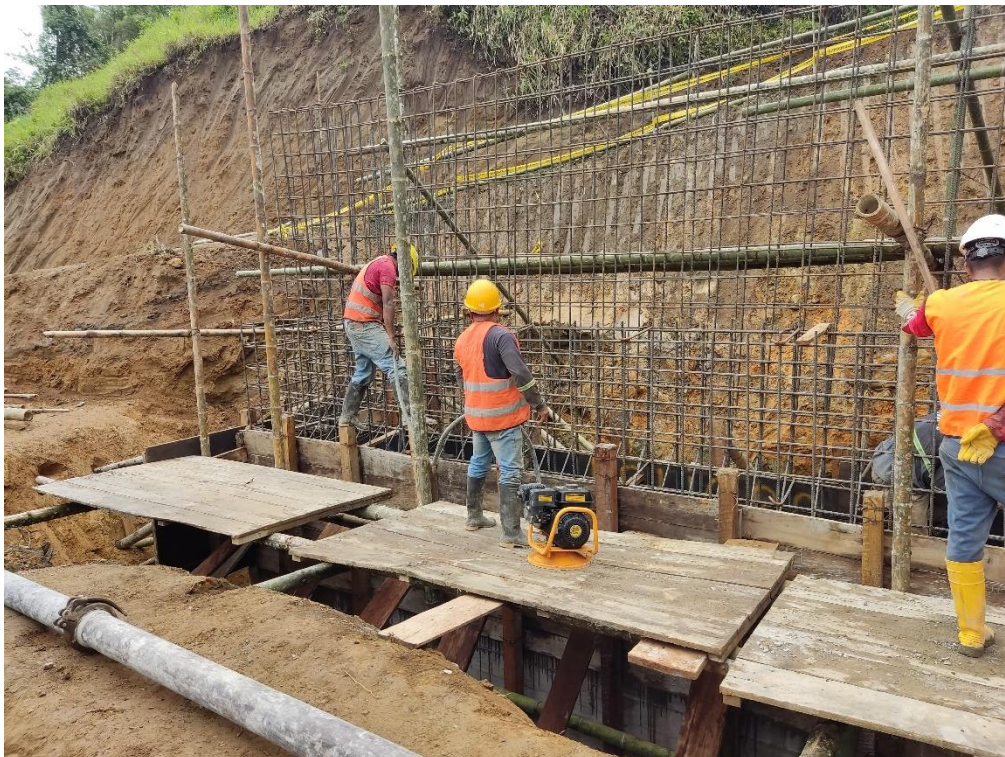
Anexo N° 12. Uso del vibrador por los trabajadores de la obra
