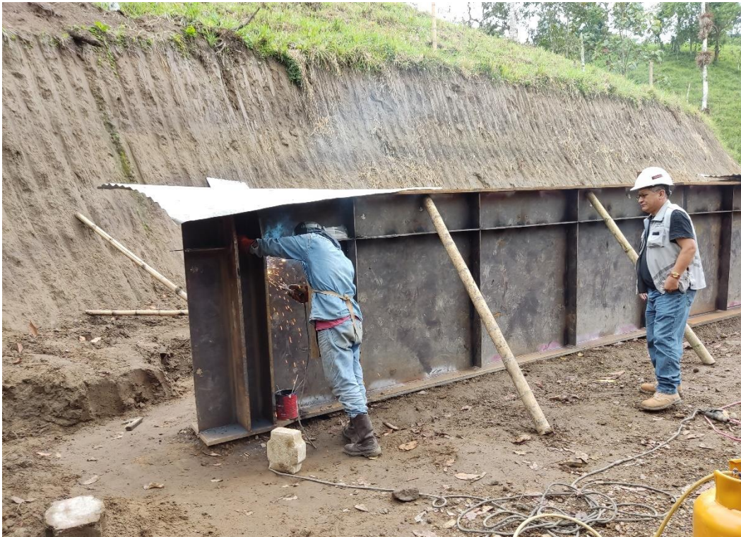
Anexo N° 11. Chaqueo de los materiales a colocar por el fiscalizador.
