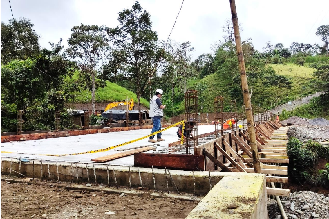
Anexo N° 11. Chaqueo de los materiales a colocar por el fiscalizador.
