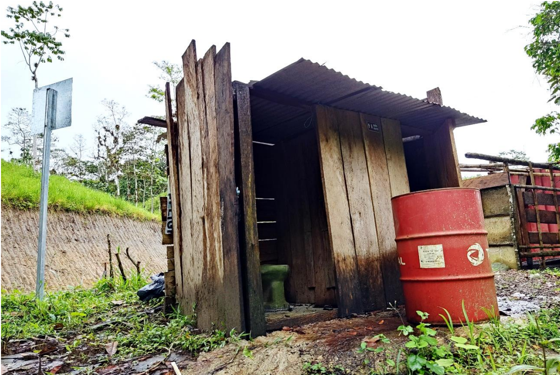
Anexo N° 9. Mantenimiento de letrina en obra
