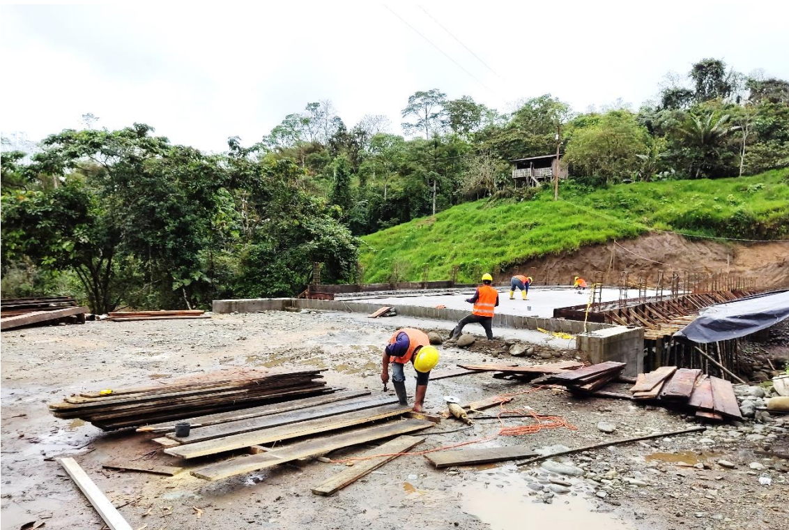
Anexo N° 10. Actividades de cortar en la obra
