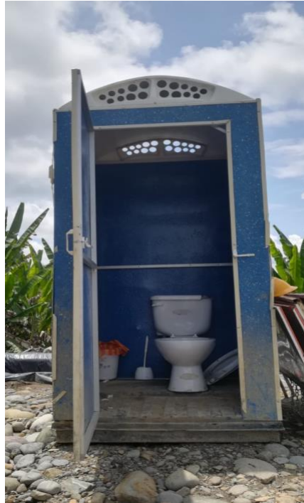
LETRINA 2: FRENTE DE OBRA 1+750
