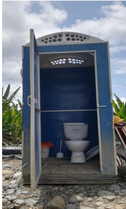
LETRINA 2: FRENTE DE OBRA 1+750
