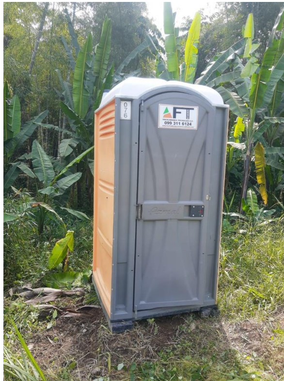
LETRINA 2: FRENTE DE OBRA 1+560
