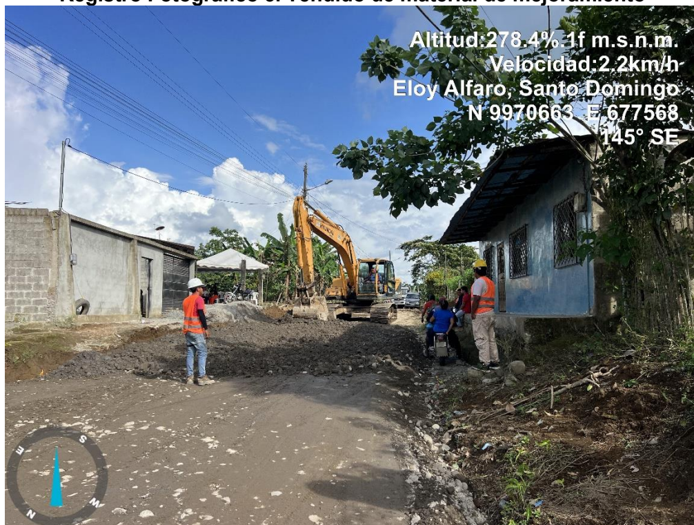
Registro Fotográfico 3. Tendido de material de mejoramiento
