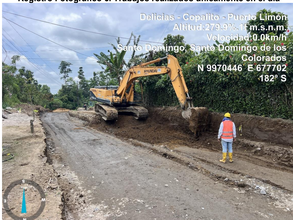
Registro Fotográfico 6. Trabajos realizados únicamente en el día
