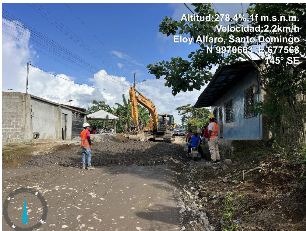
Registro Fotográfico 3. Tendido de material de mejoramiento
