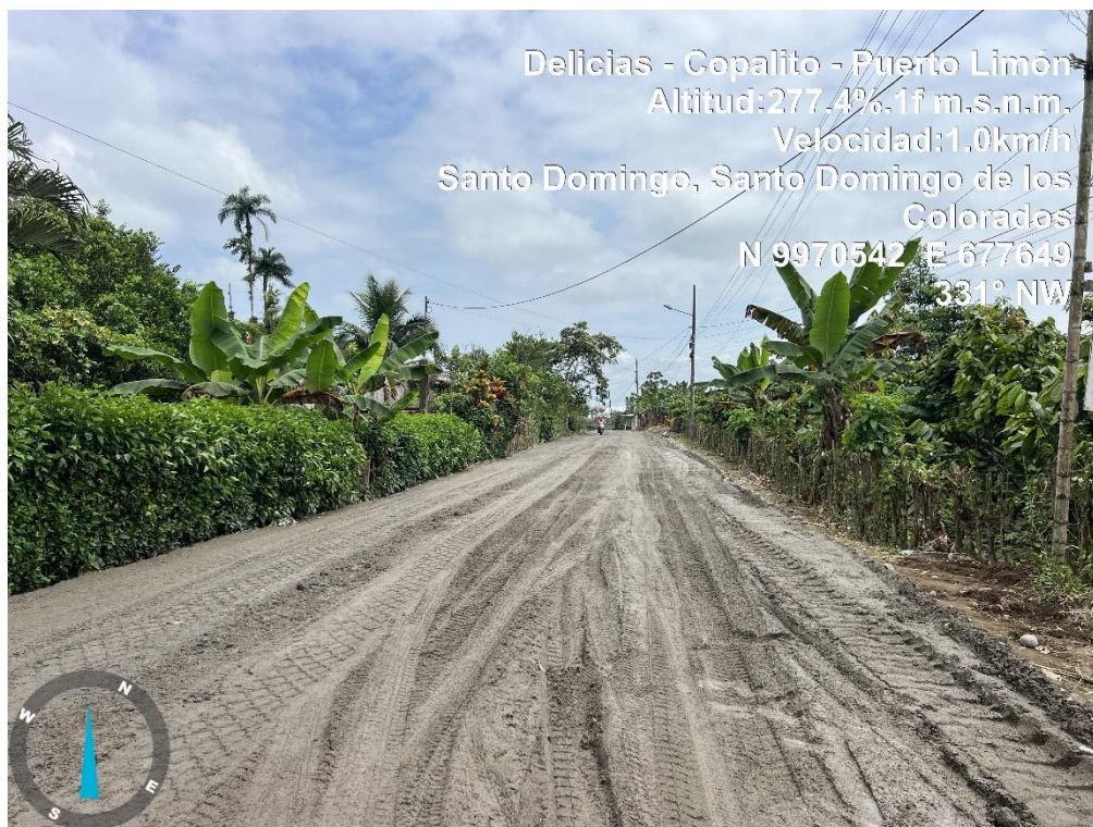
Registro Fotográfico 7. Frente de trabajo ordenado.
