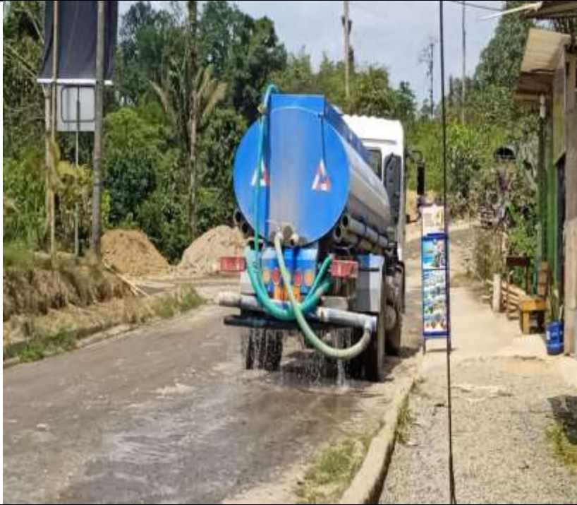
Registro fotográfico N° 01 control de polvo.
