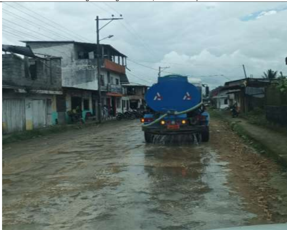
Registro fotográfico N° 01,02. control de polvo.
